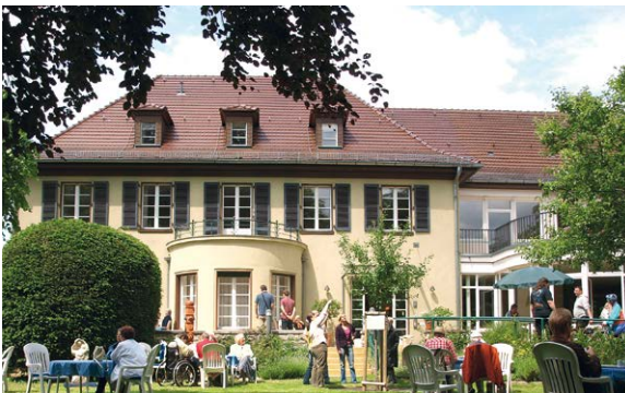
Außenansicht der Villa Donnersmarck nach dem Umbau
