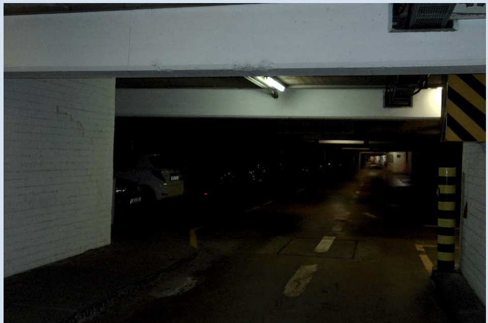
Verwinkelte Ecken im Bereich Eingang – Parkhaus
