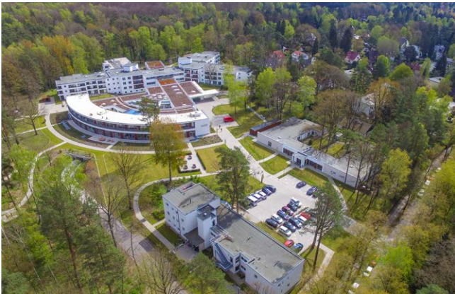
Luftaufnahme des umgebauten Fürst Donnersmarck-Hauses zum P.A.N. Zentrum 2017
