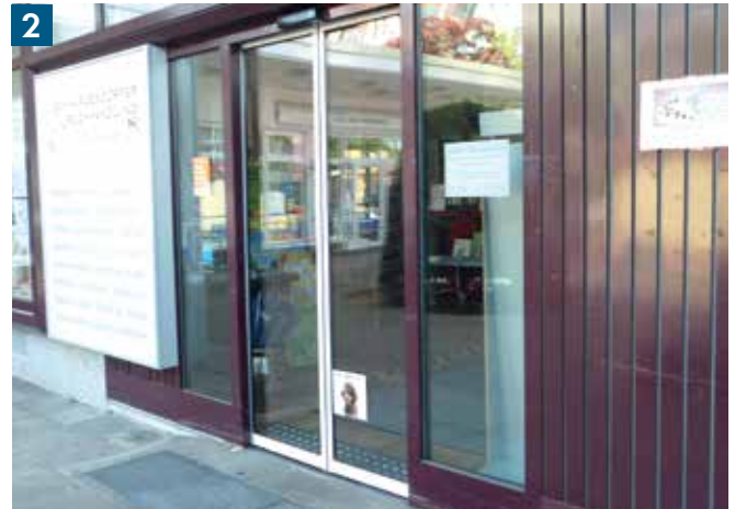
2 Ein Kontraststreifen auf der Automatiktür der Buchhandlung fehlt.
