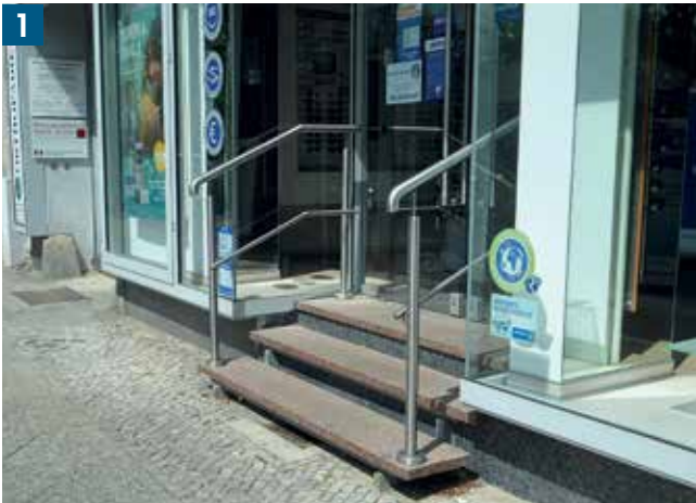
1 Treppe ohne Stufenmarkierung; der Handlauf endet vor der Stufenkante.
