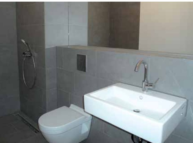
Beim Neubau sind Sanitärräume meistens nicht barrierefrei. Das Waschbecken ist nicht unterfahrbar und der Spiegel hängt zu hoch.
